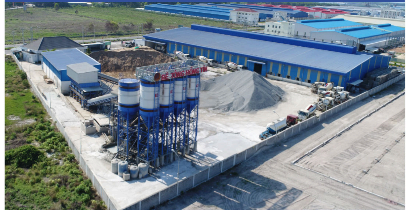
Nhà máy Bê tông Hồng Tín - Bình Dương
